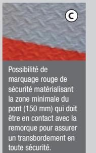
Possibilité de marquage rouge de sécurité matérialisant la zone minimale du pont (150 mm) qui doit être en contact avec la remorque pour assurer un transbordement en toute sécurité.
