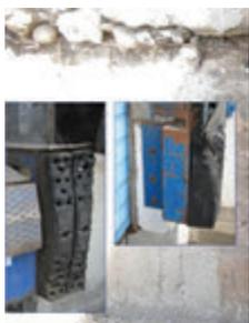
Les chocs répétés entre les camions et les quais de chargement mal protégés entraînent une détérioration inexorable des bâtiments, structures et matériels de quai.
