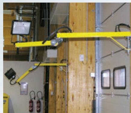
Le projecteur de quai permet d'améliorer la sécurité du personnel travaillant au chargement et déchargement des camions lorsque la luminosité à l'intérieur de la remorque est réduite ou lorsque l'on travaille en poste de nuit.
